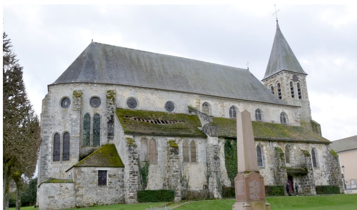
Vue du collatéral nord après la tempête de janvier 2018
